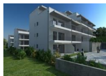
Überbauung Wibrusa Areal Schnepfwinkelstrasse 5745 Safenwil
